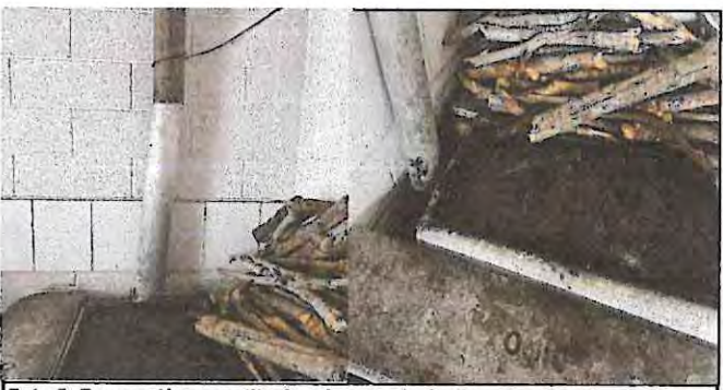
Foto 5: Reparación o sustitucion de area de Cocina: Cambio de estufa rural de tres hornillas.
