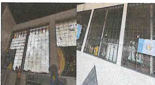
Foto 4: Ventanas: sustitucion de ventanas por PVC
