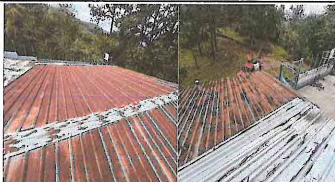
Foto1: Cubierta de Lamina: Sustitucion de lámina Troquelada por lámina troquelada C.26, aula y cocina.
