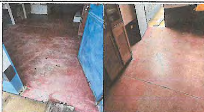
Foto 2: Piso: Sustitucion de de piso de concreto por piso cerámico
